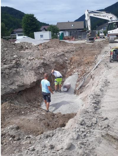
Grabungsarbeiten Wasser und Kanal für die neuen Baugründe Am Schanzel
